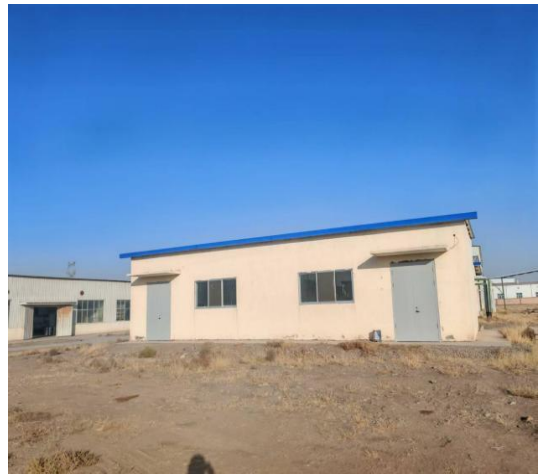
5#车间电气配电室
