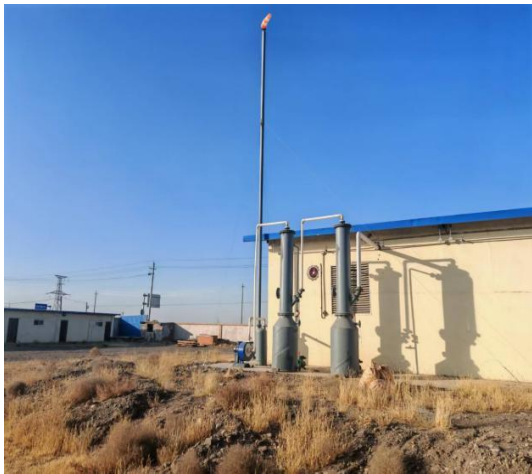
危险废物贮存库
