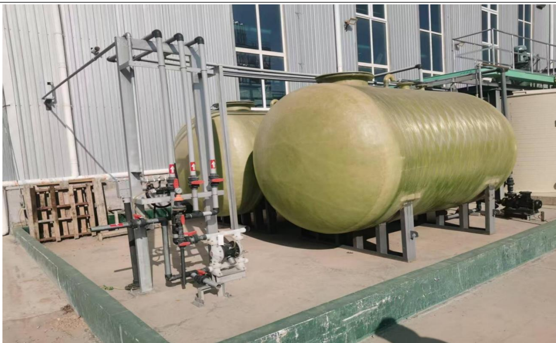
储罐区围堰
