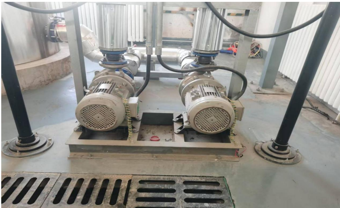
车间机泵设置基础减震
