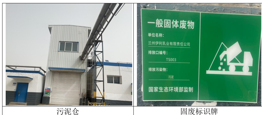
图 6 污泥处理措施现场图
