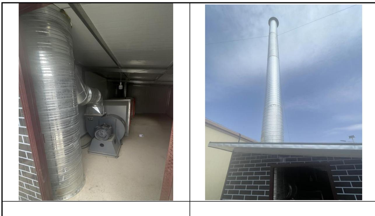
图 4.2-2 污水处理间恶臭处理装置照片
