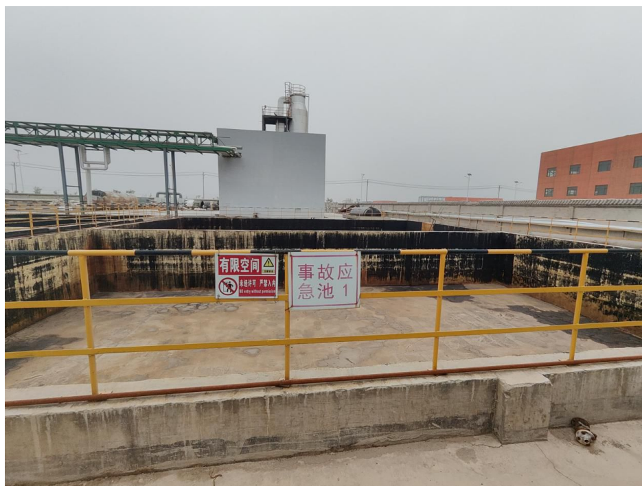
储罐区事故池 1000m 3
