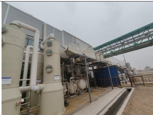
2#生产车间新建废气处理设施
