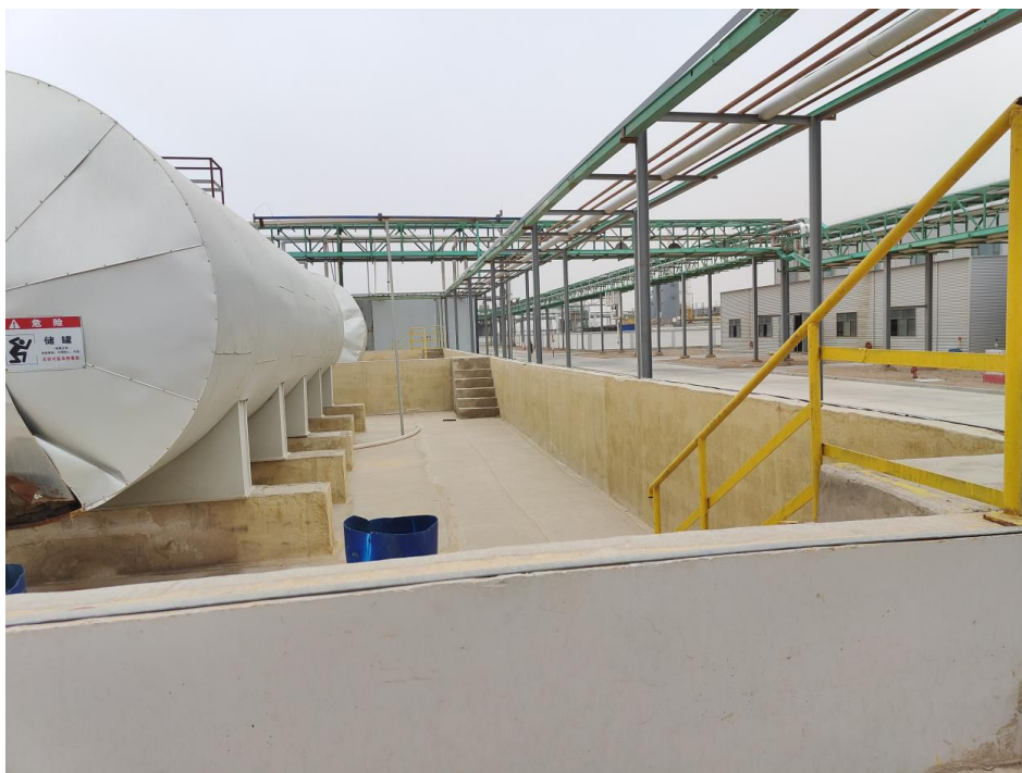
储罐区及围堰
