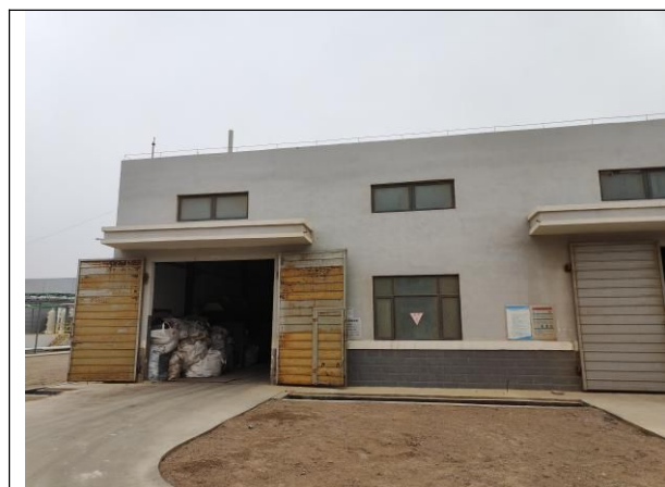
项目危废暂存库
