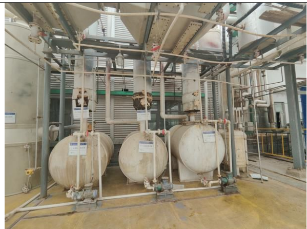
2#生产车间新建废气处理设施
