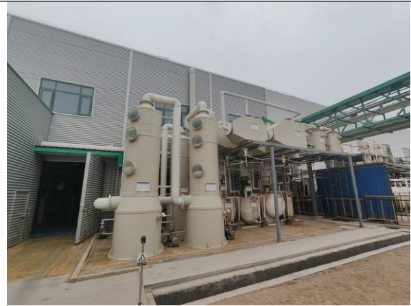
2#生产车间新建废气处理设施
