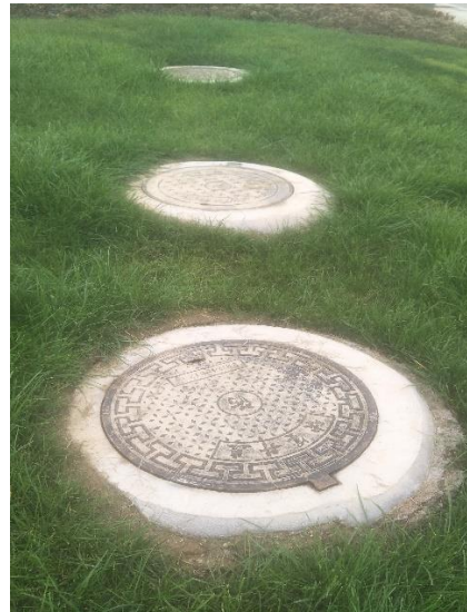
图12 体育中心化粪池
