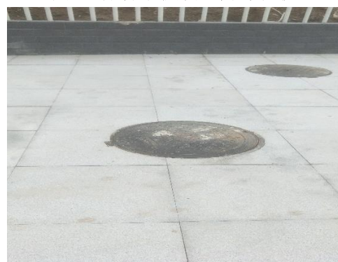
图6 体育学校隔油池
