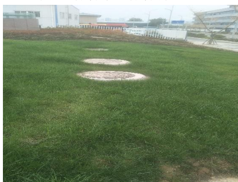
图5 体育中心化粪池
