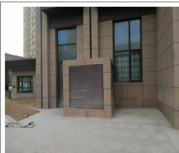
地下车库换气扇
